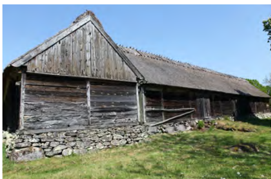
Två skånska byggnadstekniker. Överst: korsvirkeshus vid Blåherremölla gård strax söder om Maglehem. Nederst: Uthus utförda i skiftesverk vid Skåne hembygdsförbunds gård strax söder om Hanaskog. Skiftesverket är utfört med både ek- och furuplank. Foto: Thomas Thörnqvist.
