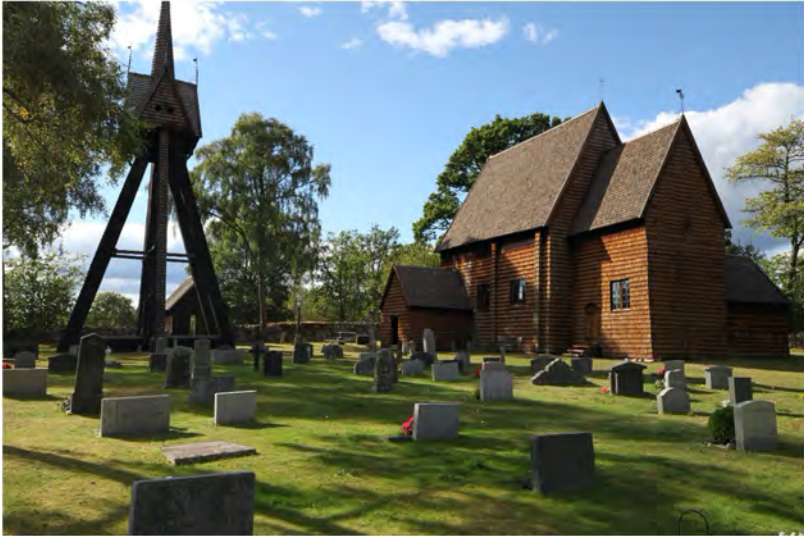
Granhults kyrka i Nottebäck, norra Kronobergs län, är en av de äldsta bevarade träbyggnaderna i landet. Kyrkan är knuttimrad. Foto: Thomas Thörnqvist.
